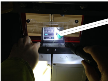
Abb. 11: Fliehkraftgewicht im Spiegel beobachten
